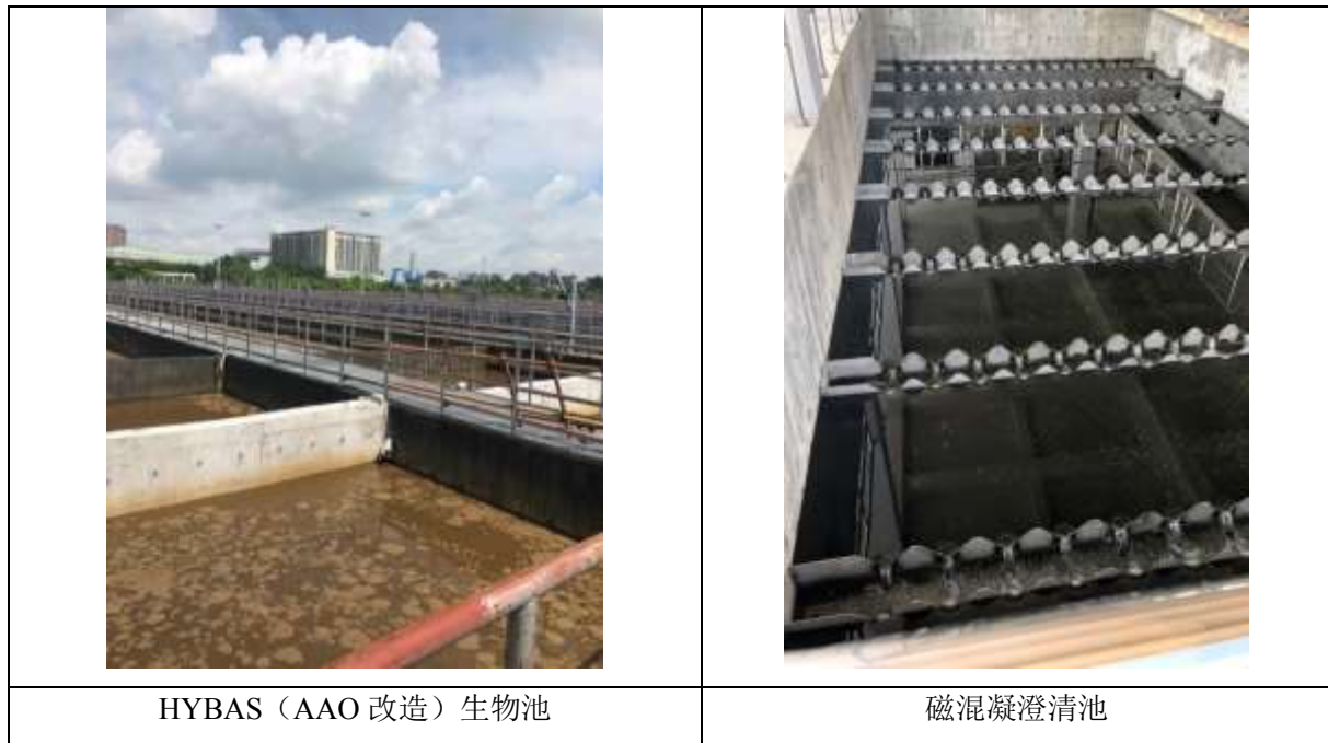
图 4.1-1 废水处理设施照片
